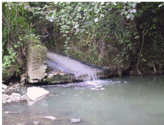
Foto 4: punto di confluenza del canale BG073-024 nel Torrente Sonna.
